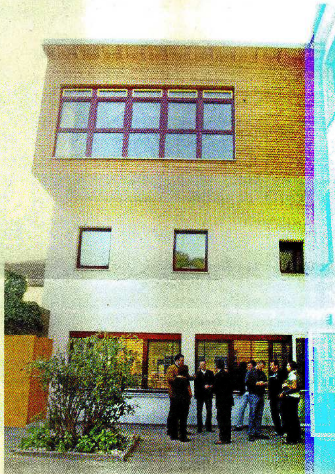
Im Erdgeschoss der Herder-Schule war der ehemalige Sitzungssaal des Gemeinderats untergebracht. Jetzt wird dort unterrichtet. Gut zu sehen ist das neue Obergeschoss, das den naturwissenschaftlichen Raum umschließt.
